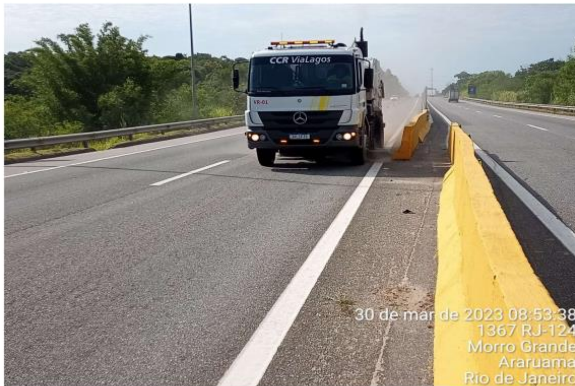
Figura 4.12 Via Lagos - Varrição de Mediana - Km 28+050 Sul
