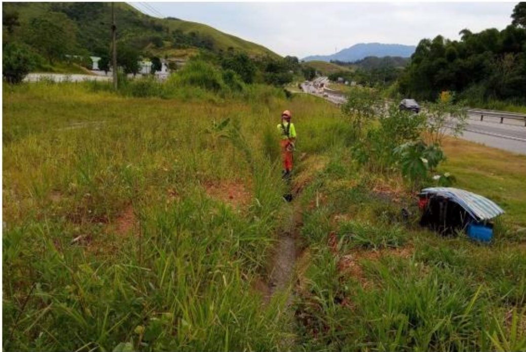
Figura 4.8 Via Lagos - Limpeza de Canaleta - Km 9+700 Norte
