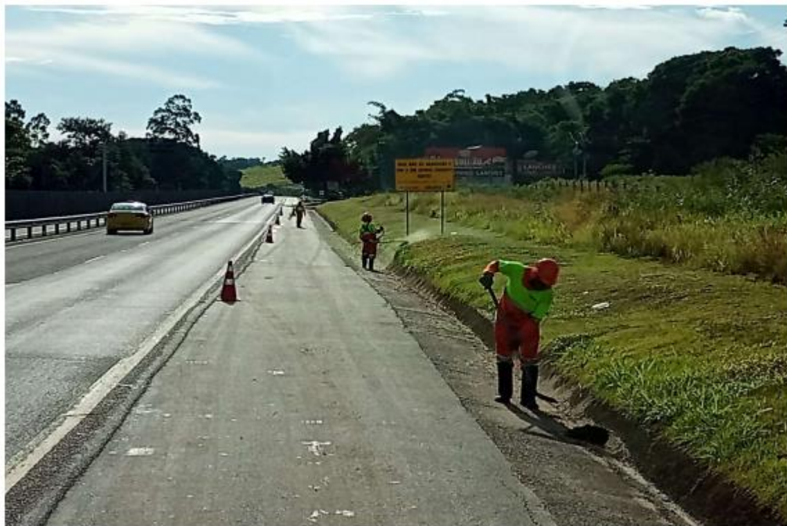
Figura 4.9 Via Lagos - Limpeza de Sarjeta - Km 24+000 Norte
