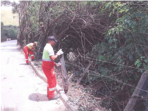
Figura 4.17 Rota 116 – Restauração de cerca – km 126 ao 127
