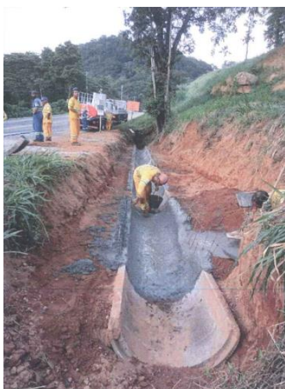
Figura 4.15 Rota 116 – Implantação de drenagem– km 98.5
