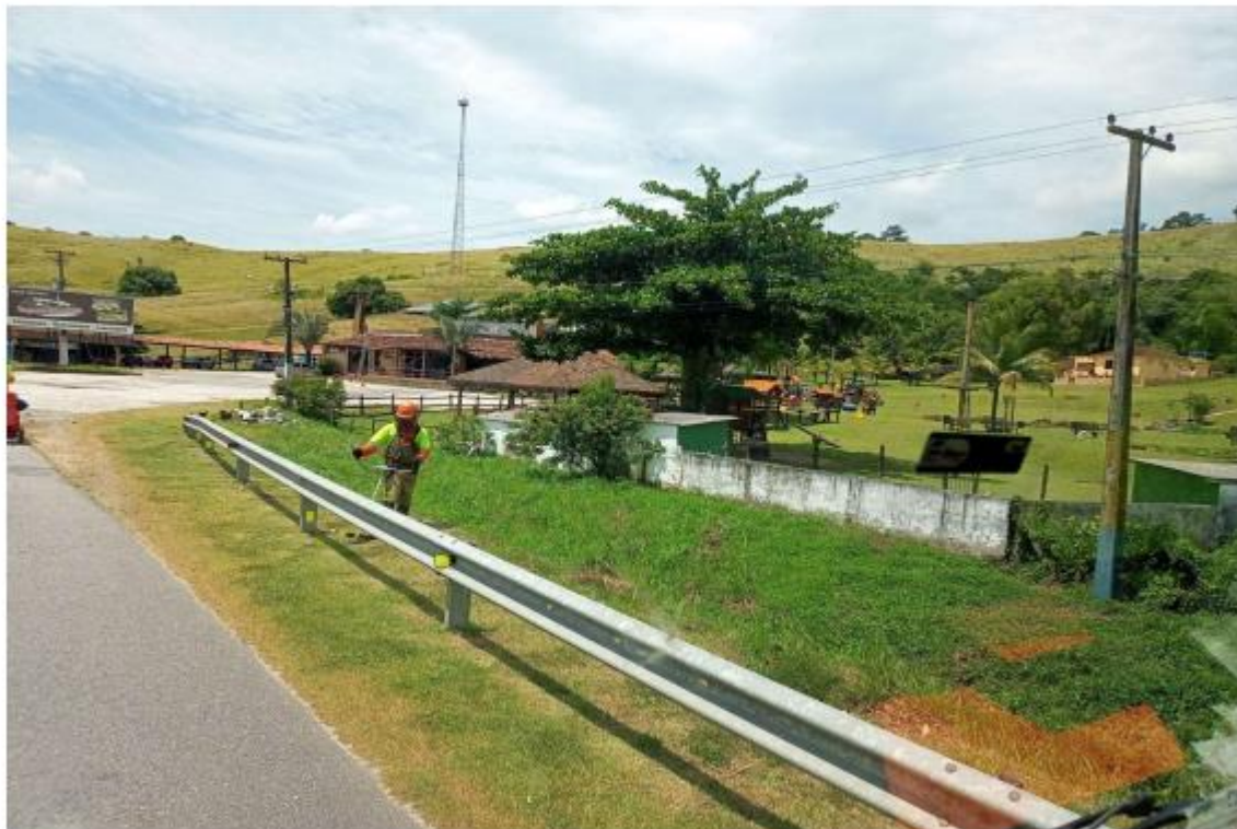
Figura 4.10 Via Lagos - Roçada Manual - Km 17+500 Norte
