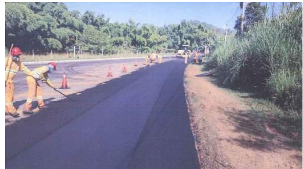
Figura 4.18 Rota 116 – Restauração de Pavimento – km 133 ao 134
