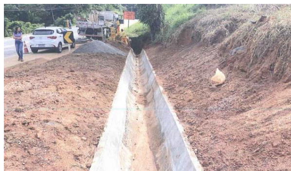
Figura 4.116 Rota 116 – Implantação de drenagem – km 98.6
