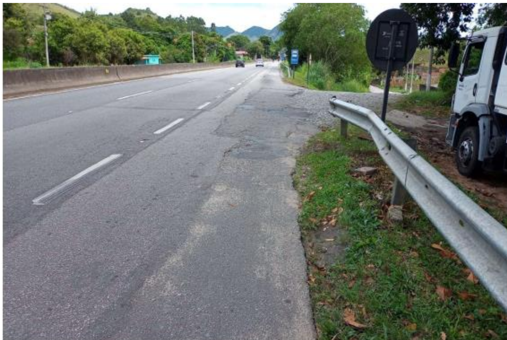
Figura 4.7 Via Lagos - Dispositivo de Segurança - Km 14+300 Sul
