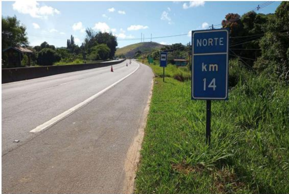
Figura 4.6 Via Lagos Manutenção de Placa - Km 14+000 Norte
